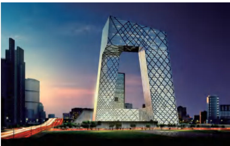
▲ 中央电视台总部大楼（2002年） 大都会建筑事务所（OMA）
