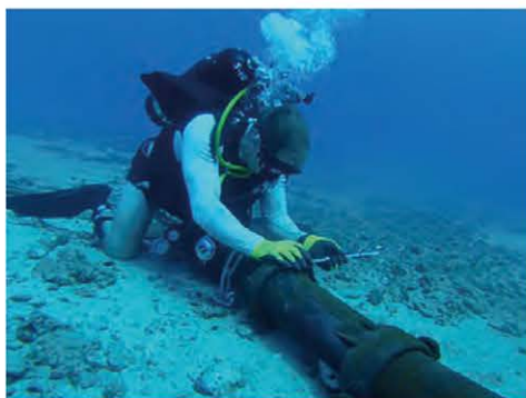
图2-3-13 正在检修的海底电缆
