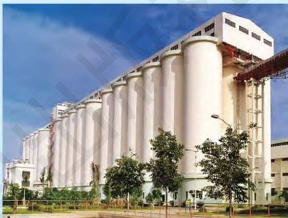
立筒仓为中储粮三大主力仓型之一，每个可存储粮食4 000吨。
