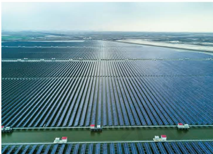
慈溪“渔光互补”光伏发电项目
