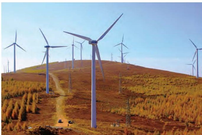
河北坝上风力发电场
