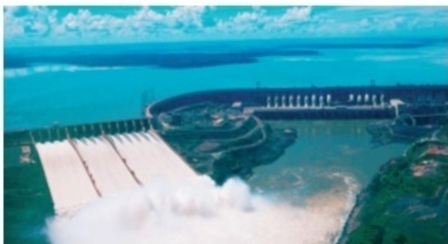
图 8-58 伊泰普水电站
