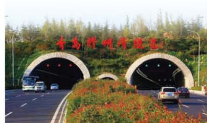
青岛胶州湾隧道入口
