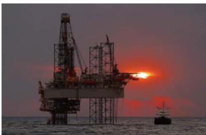
中国海上石油勘探平台
