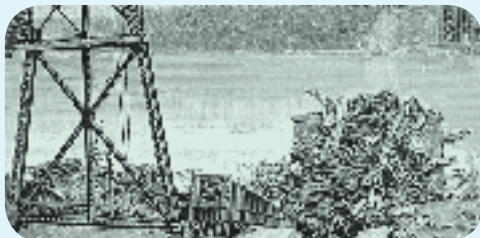
图 1-8 坍塌后的魁北克大桥
