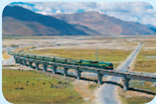
图 3-14 青藏铁路当雄特大桥
