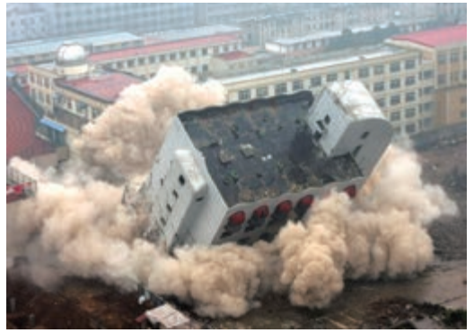
图7-17 利用炸药爆破拆除楼房
