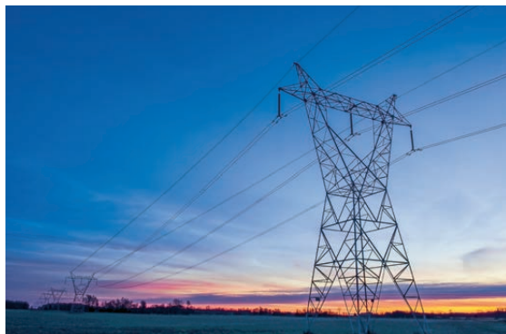
图14.3-5 高压输电铁塔最上面有两条防雷的导线
