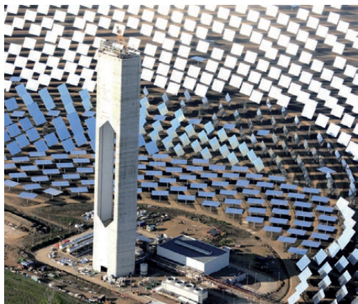
图2.2-4 塔式太阳能电站
