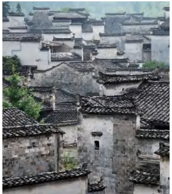
▲徽州民居 [清] 建筑 安徽黄山
