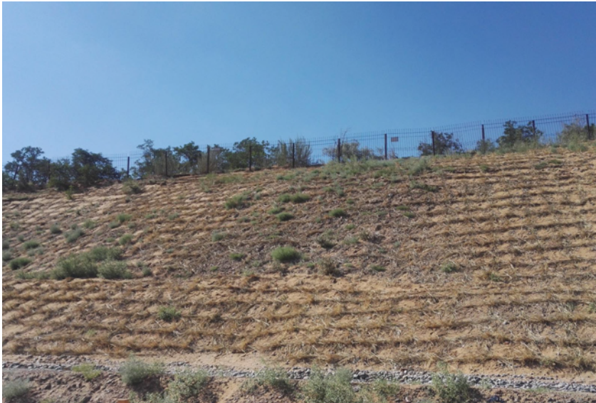
图2-3-14 沙坡头草方格沙障
