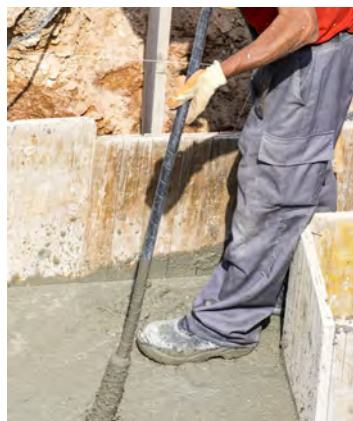
图 2-25 建筑工人用振捣器工作
