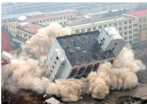
图7-17 利用炸药爆破拆除楼房
