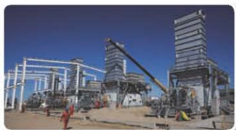
西气东输二线建设
