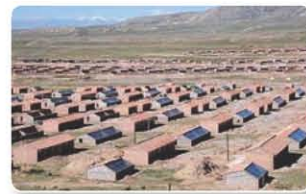
三江源地区移民安置工程
