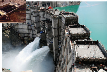
拉西瓦水电站
