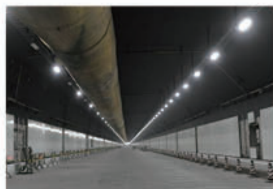
沉管隧道内部
