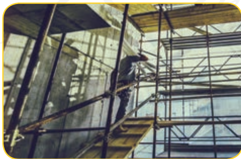
脚手架上的斜面
