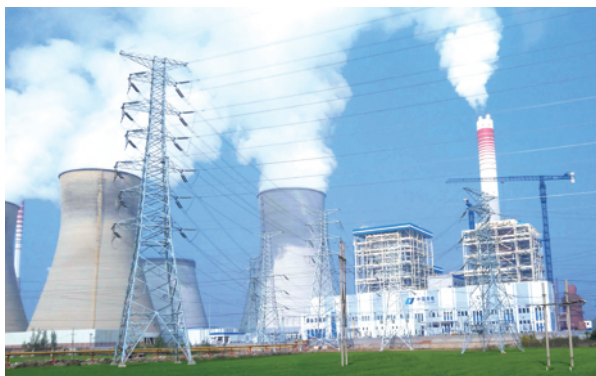
图2-4-4 安装了除尘装置的华电十里泉电厂
