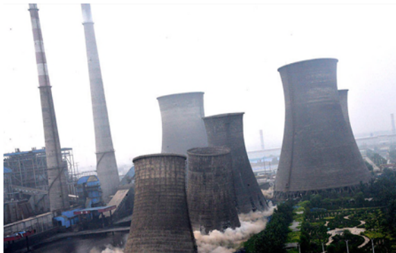
图2-4-7 淘汰落后产能“小火电”爆破现场
