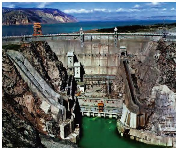
龙羊峡水电站 位于青海省东部的黄河上游。
