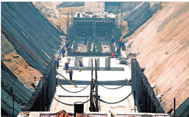
南水北调中线工程——北京段输水涵洞建设
