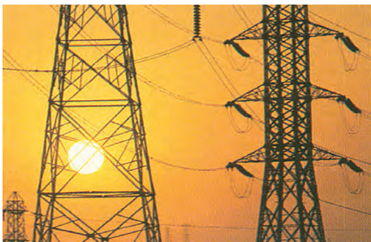
图13-44 高压输电的电压很高，用千伏作单位
