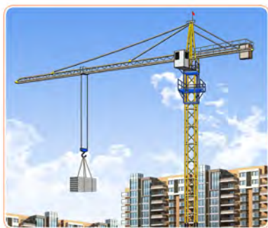
(a) 用起重机吊起大件建筑材料
