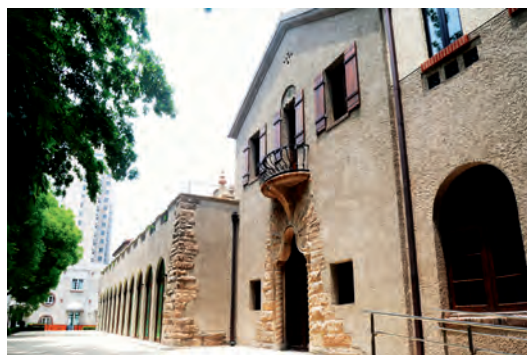
“上生新所”的巴洛克建筑
