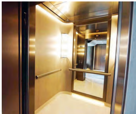
无障碍电梯 电梯内设置扶手，便于残障人士抓握；按键的高度较低，便于坐在轮椅上的人士使用。
