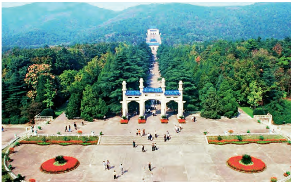
南京中山陵 吕彦直 1929 年建成 建筑按南北向中轴线对称布置在中茅山南麓的缓坡上，轴线上依次排列着广场、石坊、墓道、陵门、碑亭、石阶、大平台、祭堂、墓室等建筑。从空中往下看，中山陵的整个平面布局呈警钟形，寓有“唤起民众”之意。
