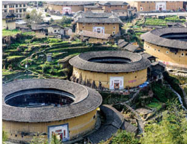
福建龙岩市永定区下洋镇圆形土楼
