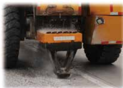
图 2-31 路面共振破碎机破碎路面
