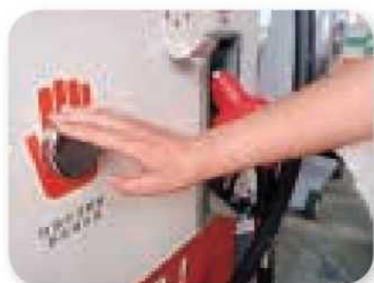
在加油站安装除静电装置
