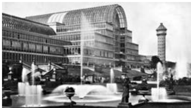
第一届世界博览会标志性建筑——水晶宫 帕克斯顿（英国）1851年以钢铁为骨架、玻璃为主要建材的建筑，象征工业时代的新式建筑。
