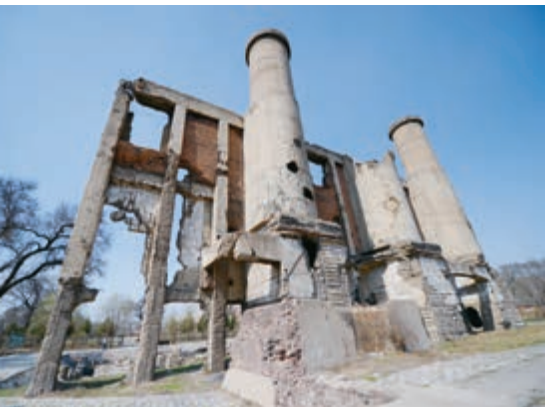
▲ 侵华日军731部队锅炉房遗址
