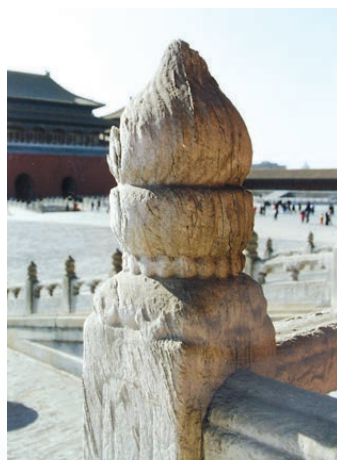
图18.4-3 被酸雨严重腐蚀的汉白玉石柱
