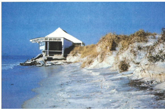
全球气候变暖导致海平面上升，海边建筑物遭到破坏
