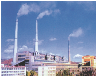
给烟囱安装上除尘装置
