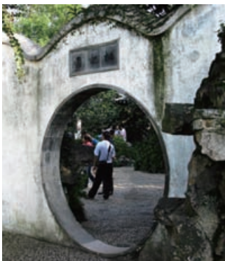
▼苏州拙政园枇杷园内起隔景和框景作用的云墙和洞门。
