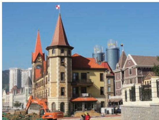
现代城市建筑（山东烟台）
