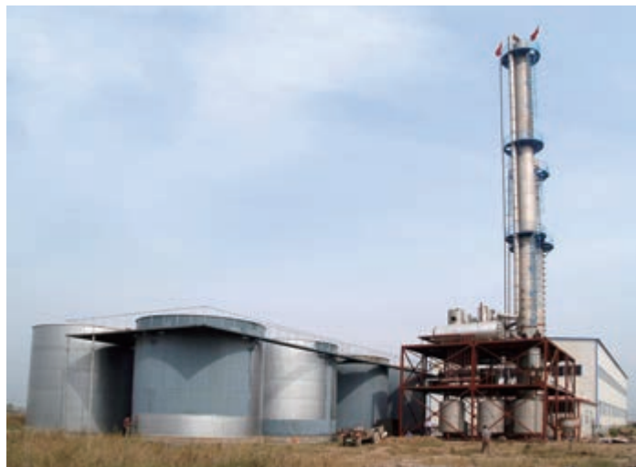
图4-6 我国建成的高粱秸秆制燃料乙醇生产装置
