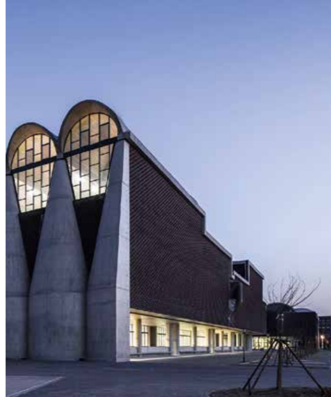
天津大学新校区综合体育馆
