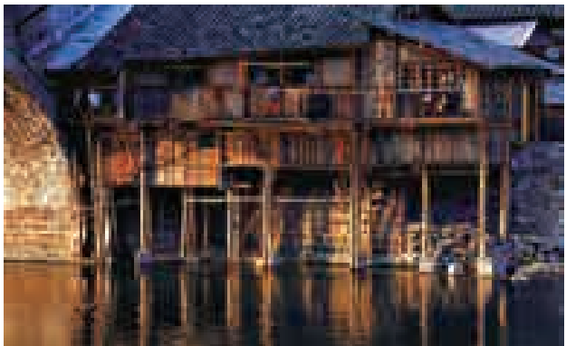
传统木结构民居湘西吊脚楼
