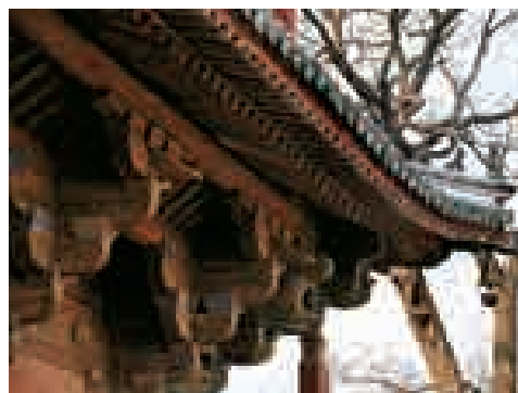
古建筑上的斗拱
