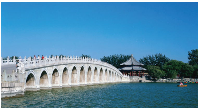
北京颐和园的十七孔桥始建于清朝乾隆年间，桥身和桥拱的面中间高，两边低，形成优美的抛物线
