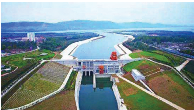
图 1.5 南水北调中线陶岔渠首
